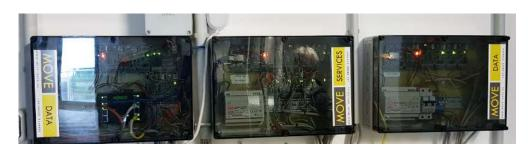
Die AREAL Gebäudeleittechnik MOVE-data – verbindet dezentrale Strom – und Wärmeerzeuger und -Verbraucher optimal.
